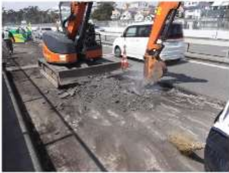
舗装撤去状況
