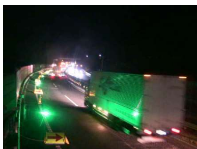
視線誘導の設置例
