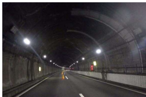
岡谷トンネル
